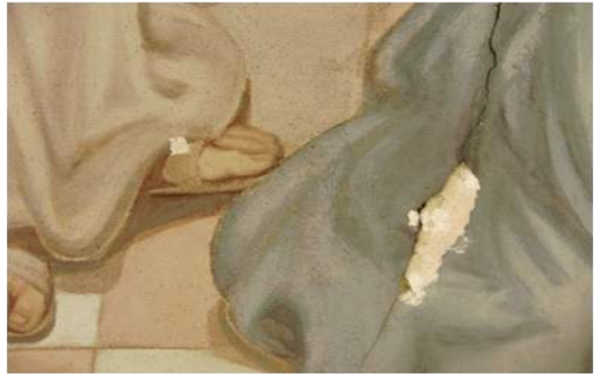
Fot 3. Odkrywka na sklepieniu nawy. Niewielka sonda oraz naturalny ubytek warstwy malarskiej wraz z częściowo wykruszonym tynkiem nie wykazuje istnienia warstw wcześniejszych w tym miejscu
